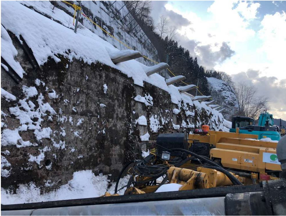
花輪線復旧工事：令和5年2月6日
